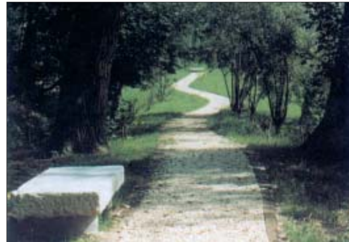
Foto n. 38 - Fontana di Venchieredo, Sesto al Reghena, Pordenone: veduta di un percorso con pavimentazione in pietrisco compattato e cordoli laterali in legno, riconoscibili dai non vedenti mediante percussione con il bastone (progetto arch. P. De Rocco).
