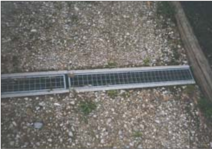
Foto n. 19 – Sentiero accessibile Monte Gusella a Pove del Grappa. Canaletta di tipo Pircher.
