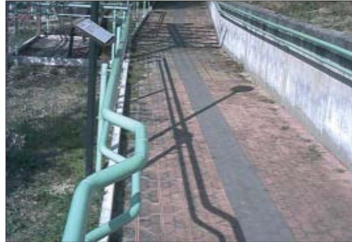
Foto n. 18 - Centro di Riabilitazione per sordociechi e pluriminorati sensoriali, Osimo (AN). Corrimano con curvatura a forma di U che allarga il percorso in corrispondenza di un punto informativo o di particolare interesse.
