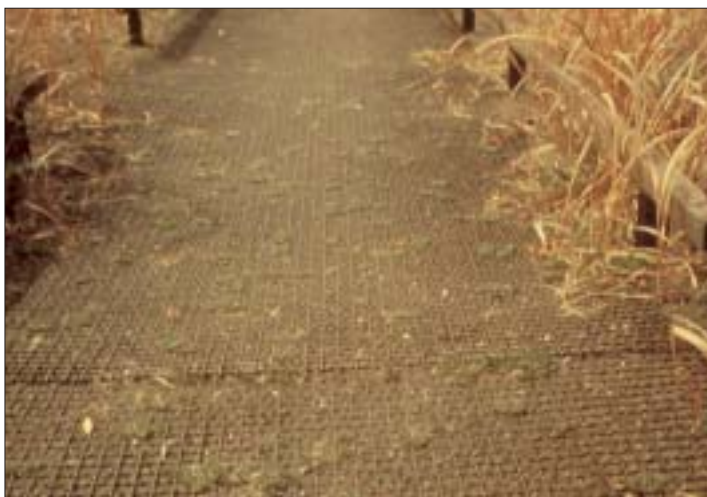
Foto n. 42 - Parco Nazionale del Circeo: interessante l'uso della rete elettrosaldata su fondo sabbioso.
