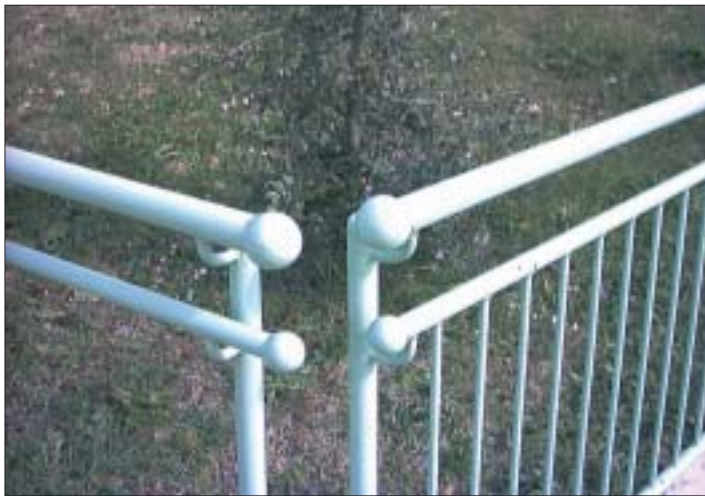
Foto n. 16 - Centro di Riabilitazione per sordociechi e pluriminorati sensoriali, Osimo (AN.) Fine del corrimano a forma di sfera.
