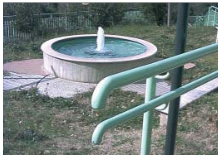
Foto n. 15 - Centro di Riabilitazione per sordociechi e pluriminorati sensoriali, Osimo (AN). Corrimano piegato verso il basso.
